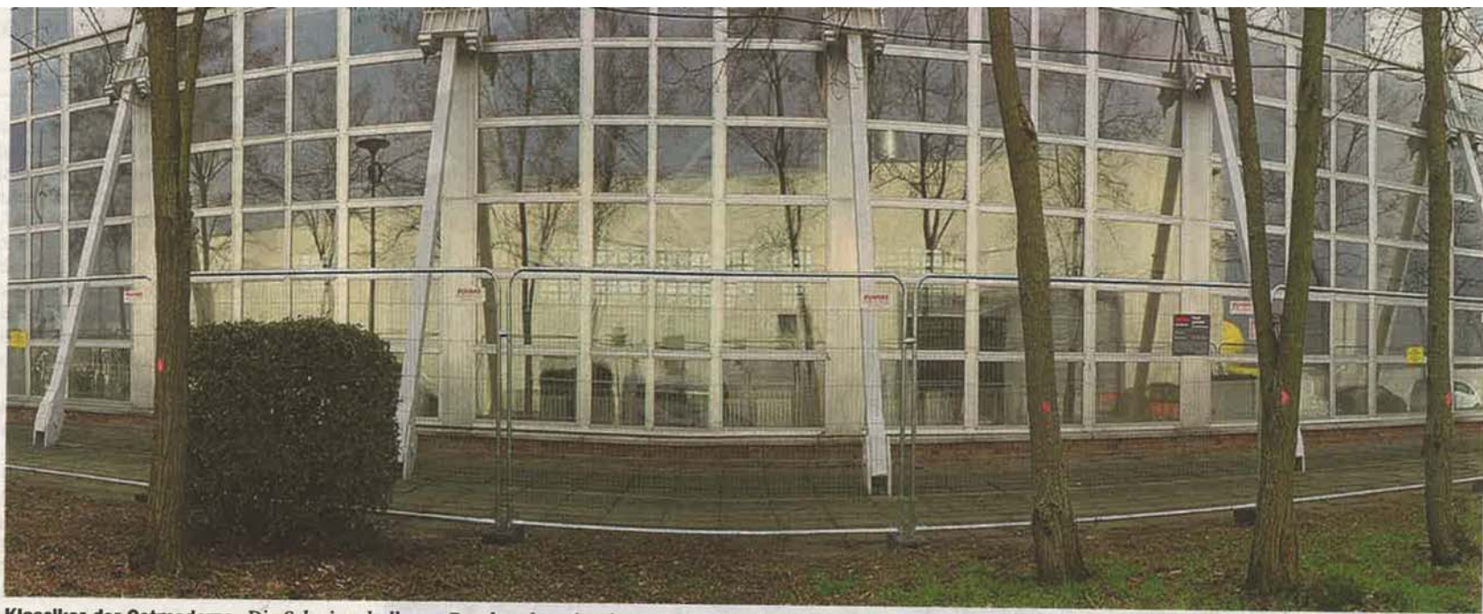
Klassiker der Ostmoderne. Die Schwimmhalle am Brauhausberg ist eine von vier baugleichen Typs, die es in der DDR gab. Der Prototyp in Dresden steht unter Denkmalschutz, die Potsdamer Halle ist die einzige, die abgerissen werden soll. Christian Keller plädiert für einen differenzierten Umgang mit DDR-Bauten. Foto: Andreas Klaas
